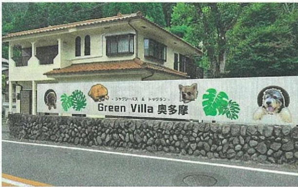
▲Green Villa 奥多摩の外観
